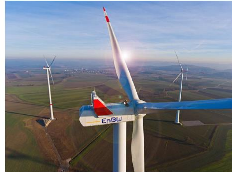
EnBW- Windpark Rot am See
