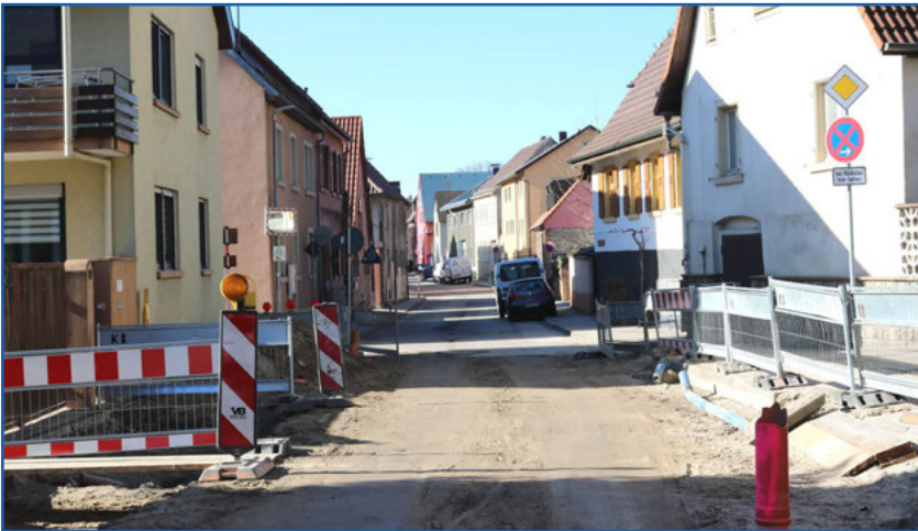
Engstelle Höhe Sohlweg
