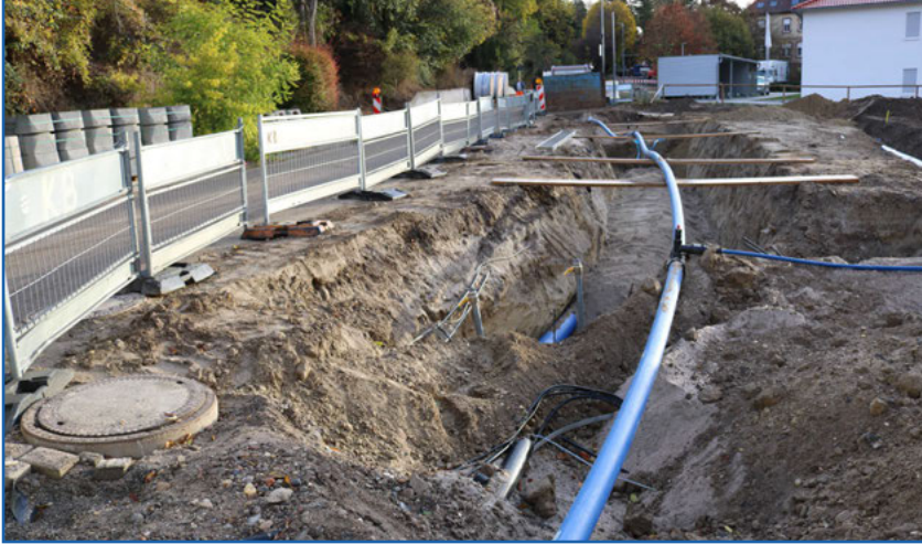
Während der gesamten Bauzeit wurden die Anwohner mit Notleitungen wie dieser versorgt
