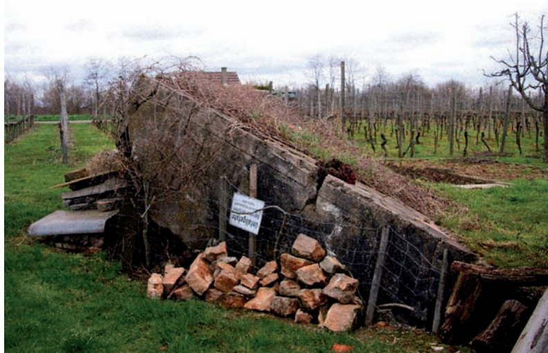
Die einzig verbliebene Ruine nach dem Regelbauwerk F in Weingarten mit ihrer schräg liegenden Decke bei den Weinbergen.
