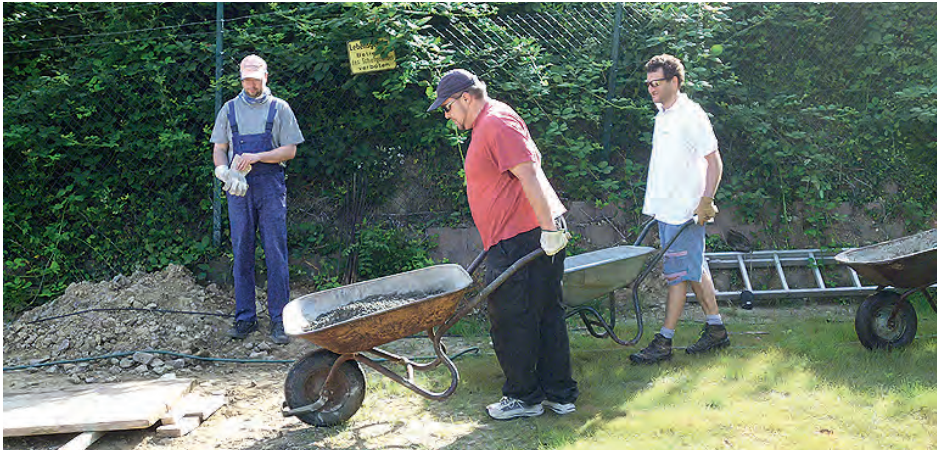
Viele Schubkarren Beton wurden transportiert
