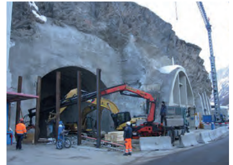
Erweiterung des Schlammbehandlungsgebäudes im Inneren des Matterhornmassivs
