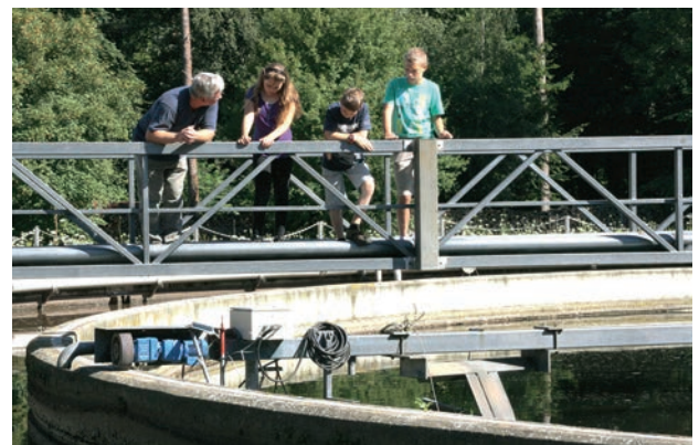
Eine „Inspektionsfahrt“ auf der Brücke war für die Ferienspäßler der Höhepunkt der Besichtigung der Kläranlage
