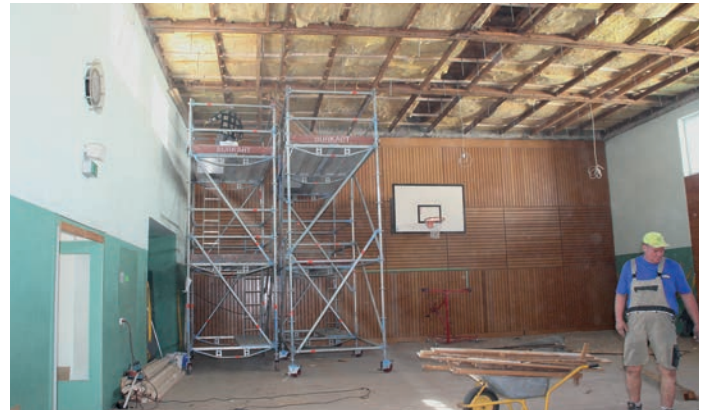
Umbau in der Sporthalle
