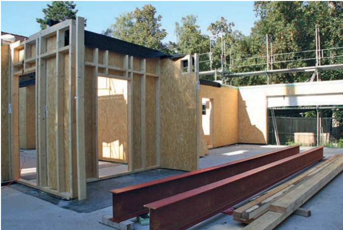
Blick in den künftigen Speisesaal
