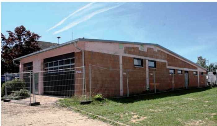
Der Anbau zwischen Feuerwehrhaus und Mineralix-Arena ist im Rohbau fertiggestellt
