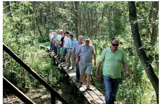
Der Steg zum Moorsee ist baufällig geworden und soll in 2015/16 erneuert werden
