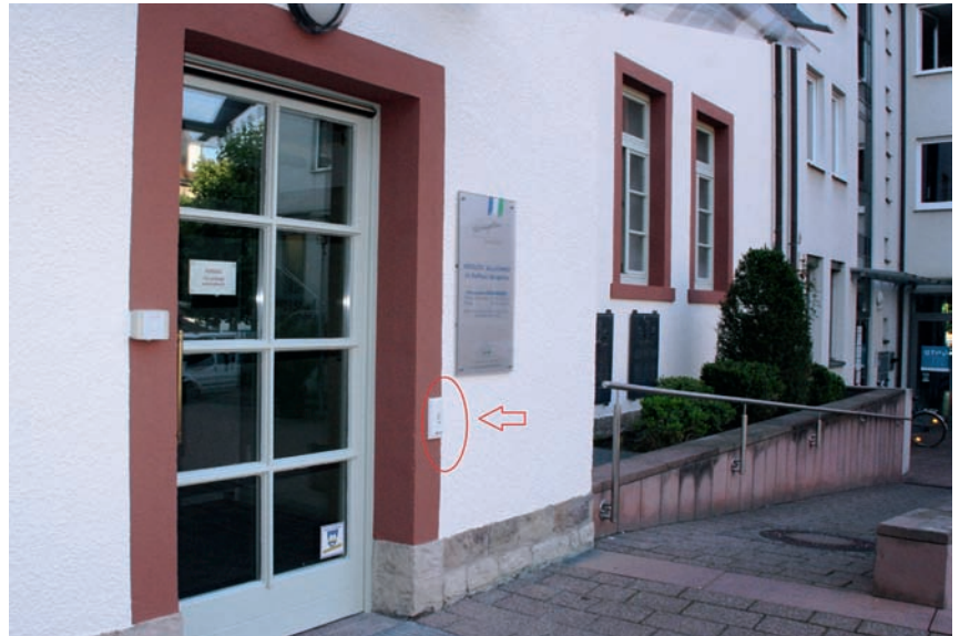
Das Rathaus ist auf der Rückseite über eine Rampe zugänglich. Am rechten Türrahmen befindet sich ein leicht erreichbarer Schalter, der die Tür öffnet
