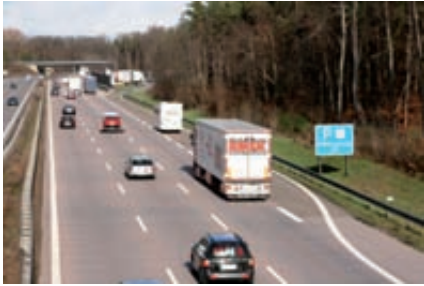
Parkplatz Höfenschlag, der nördlichste Punkt von dem aus der Wall nach Süden gebaut werden soll.
