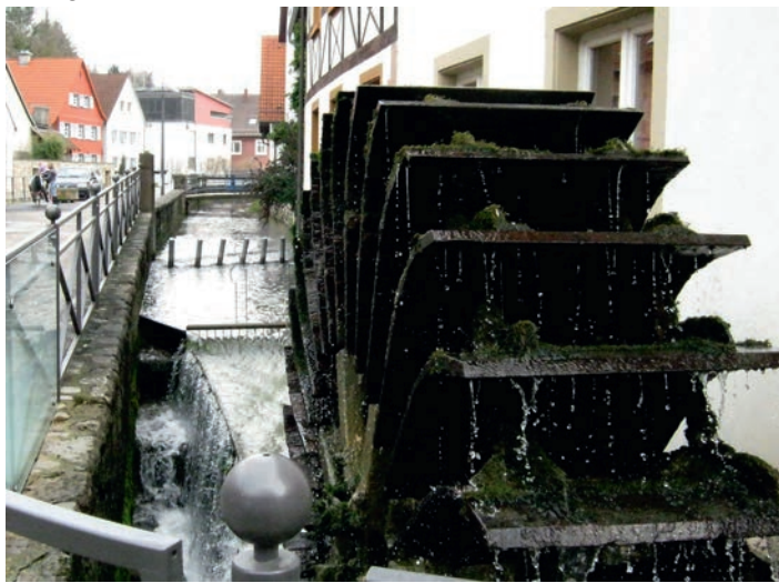
Das Wasserrad der Gemeinde wird seit seiner Installation 2011 ehrenamtlich von einer Arbeitsgruppe des Bürger- und Heimatvereins gewartet. Fotos: prf
