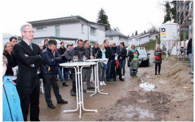
Ein Wohngebiet mit 14 Reihenhäusern entsteht „Am Gipfelsberg“. Dort war jetzt Richtfest.
