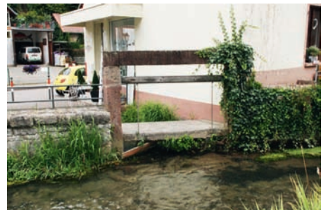
Mehrere Wehre sind bereits oder sollen wieder gangbar gemacht werden. Hier das Wehr an der Jöhlinger Straße
