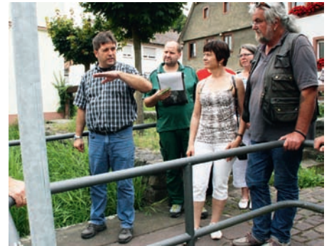
Einige Brückchen über den Walzbach sind aufgrund ihrer geringen Höhe ein Abflusshindernis
