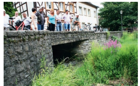
Dieser Bypass in der Jöhlinger Straße soll den Bach bei Hochwasser entlasten
