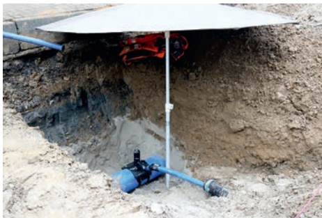
Ein Druckanbohrventil
