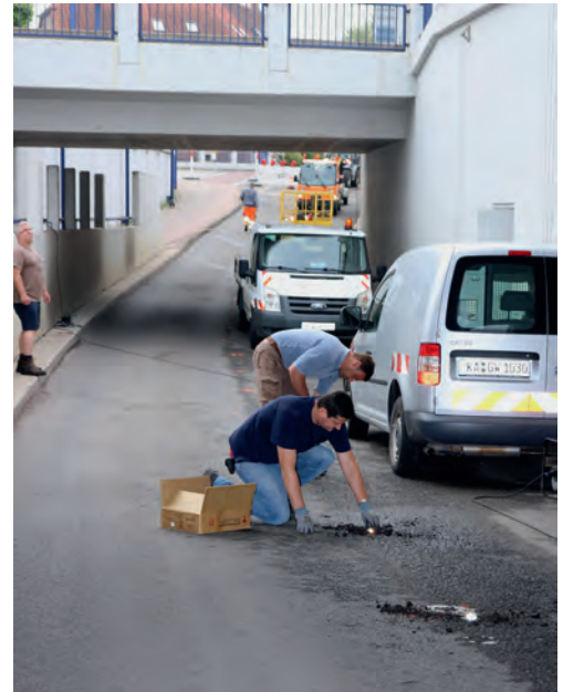
Bauhofsleiter Dirk Pfirrmann und Gerd Weinbrecht, im Ortsbauamt zuständig für Tiefbau, setzen die Glasknöpfe ein
