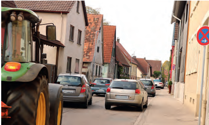
Der Bereich zwischen der Abzweigung Sohl und Katzenbergweg ist der engste Abschnitt und soll als Bauabschnitt 2 saniert werden
