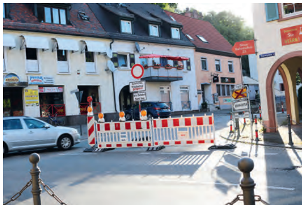
Nur der erste Abschnitt bis zur Abzweigung zum Sohl ist noch befahrbar.
