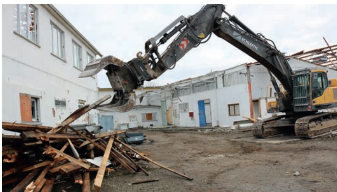
Sortenreines Ablagern der Materialien ist Pflichtaufgabe bei Abbrucharbeiten, die heute eher als „selektiver Rückbau“ bezeichnet werden.
