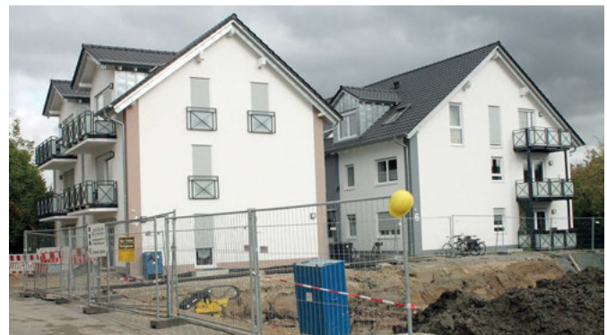
Hinter der Baugrube erkennt man die bereits realisierten beiden Neubauten Mülbergerstraße 6 und 4, die jeweils von sechs Mietparteien bewohnt sind.
