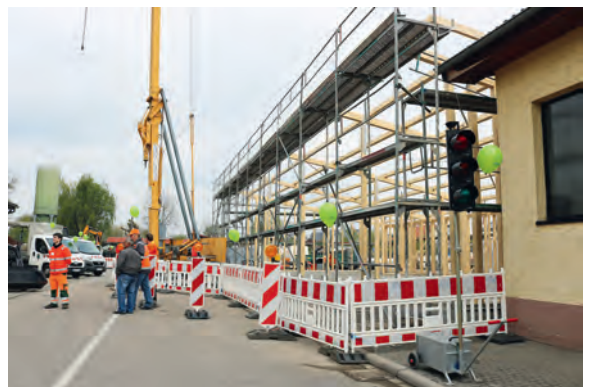
Die noch im Bau befindliche Lagerhalle
