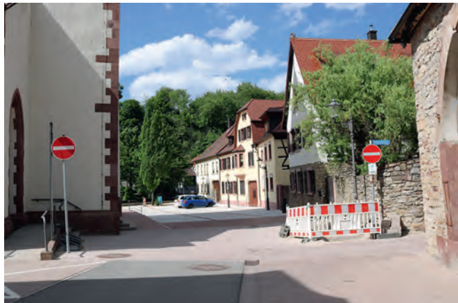
Unübersehbare Schilder weisen auf die Einbahnstraßenregelung hin
