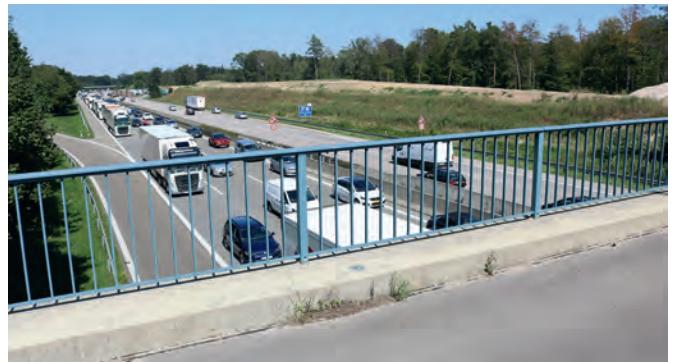
Blick nach Norden auf den zweiten Bauabschnitt
