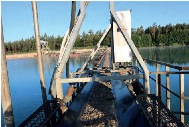
Auf 700 Meter Länge transportieren die Förderbänder das Material vom Baggerkopf bis zum Vorsieb
