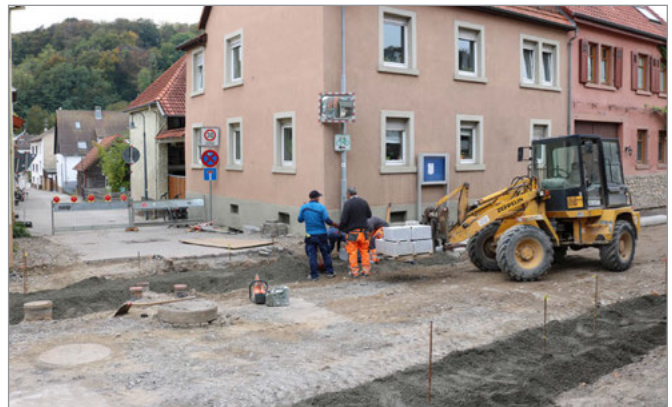
Baggerarbeiten bei der Mühlstraße
