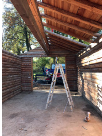
Abbau des alten Bootshauses
