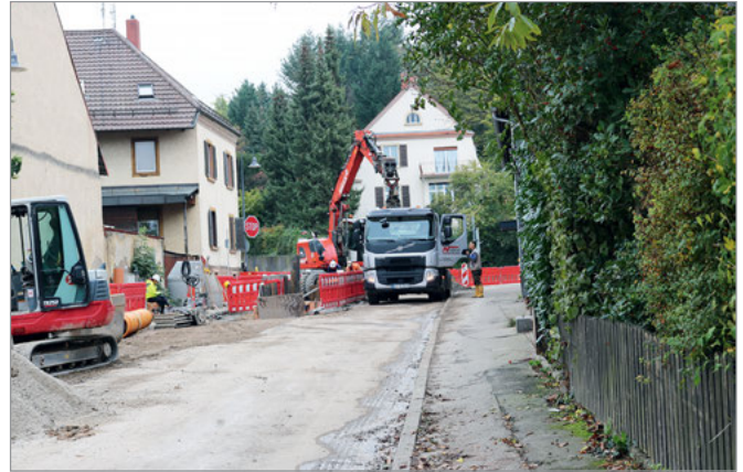
Letzte Arbeiten am zweiten Bauabschnitt
