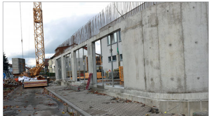
Der Bau außen entlang der Ringstraße
