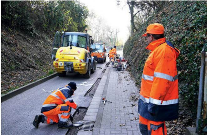
Zur Gewährleistung der Verkehrssicherheit musste deshalb an acht Stellen der Asphalt ausgetauscht werden. Dazu wurden die betroffenen Stellen zunächst markiert und mit dem Asphaltschneider herausgeschnitten. Die Mitarbeiter des Bauhofs haben im Anschluss die Stellen gereinigt und ein Fugenband eingesetzt. Das Band soll als Verbindungsstück zwischen dem neuen und alten Belag dienen und dafür sorgen,
