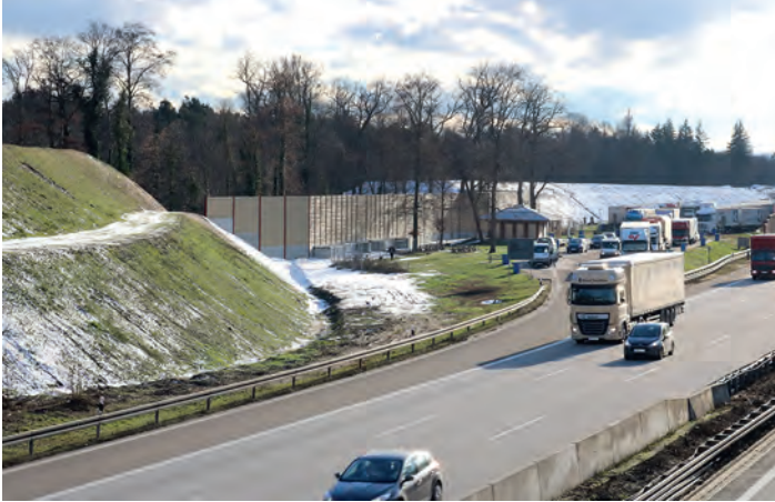
Die Lärmschutzwand am Parkplatz „Höfenschlag“
