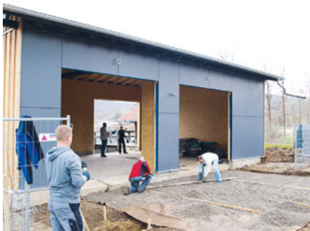
Vorbereitungen für die spätere Zufahrt zum neuen Boots- und Garagengebäude
