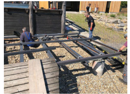
Arbeiten an der neuen Stahlunterkonstruktion
