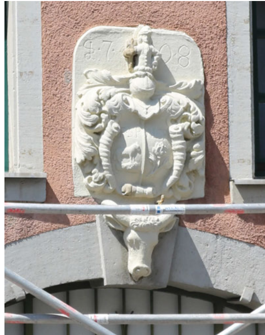
Das Wappen mit Grundierung vor dem Farbauftrag
