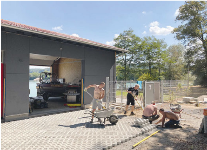
Auch beim Bootshausbau geht es stetig voran, jeden Samstag wird fleißig „geschafft“. Aktuell wird die Einfahrt hergestellt.
