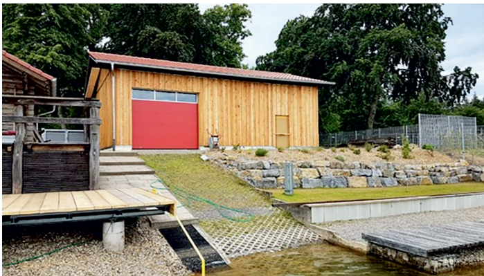
Die neue Boots-/Fahrzeughalle am Baggersee - die Endphase der Crowdfunding-Aktion für die Abschlussfinanzierung
