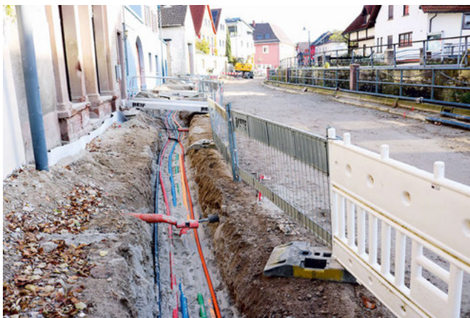
Die Breitbandverlegung ist in der Endphase
