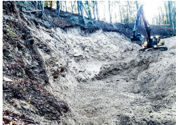
Steinbruch Bärenental - so sieht die Fläche im Zuge der Aufwertungsarbeiten aus
