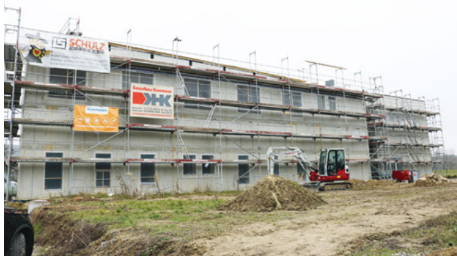
Die Fassade des neuen Vereinsheims des TSV am Ortsrand Richtung Weingartner Moor wirkt schon beeindruckend
