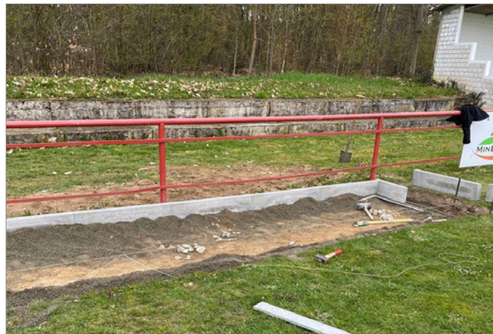
Das Fundament der Auswechselbänke vor dem Ausfüllen mit dem Beton
