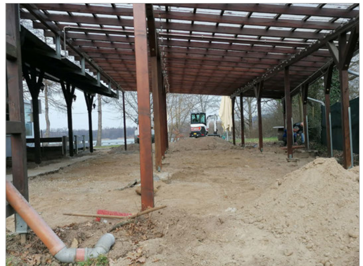
Während des Umbaus
