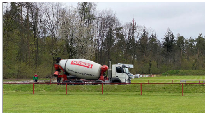
Anlieferung des benötigten Betons
