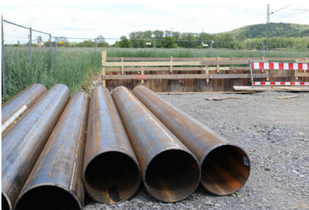
Mehrere Stahlrohre werden hintereinander zusammengeschweißt
