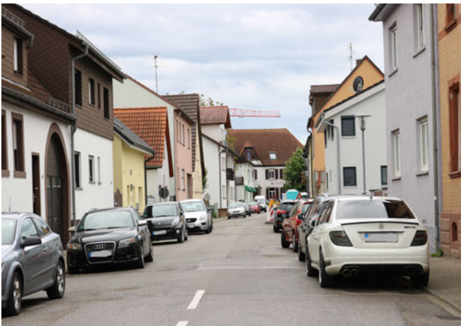
„Ist-Zustand“ der Paulusstraße mit Blick nach Süden zur Bahnhofstraße
