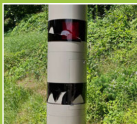
Zeugen gesucht: Blitzer beschädigt Seite 9
