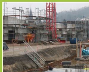
Baufortschritt „mittendrin leben“ Seite 6
