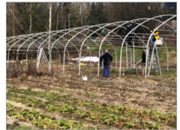
Tunnelaufbau auf dem Walzbachacker
