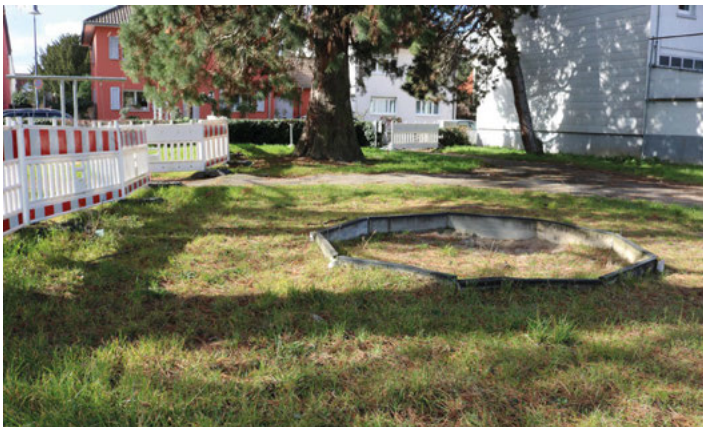
Dieser Teil des Spielplatzes könnte freigegeben werden, solange er nicht als Materiallager benötigt wird
