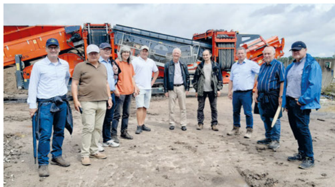
Bürgermeister Bänziger (v.l.n.r.), Gemeinderäte, Dr. Andreas Schell (Mineralix GmbH) und Oliver Russel (Fachbereichsleiter) besuchen am 29. Juli die Baustelle
