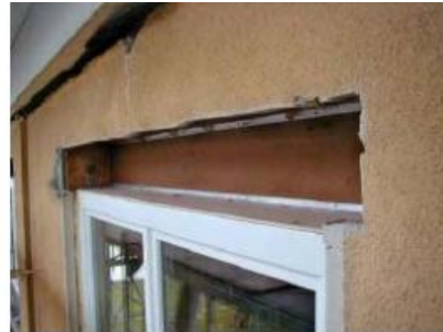
Aussägen von Außenschürzen
