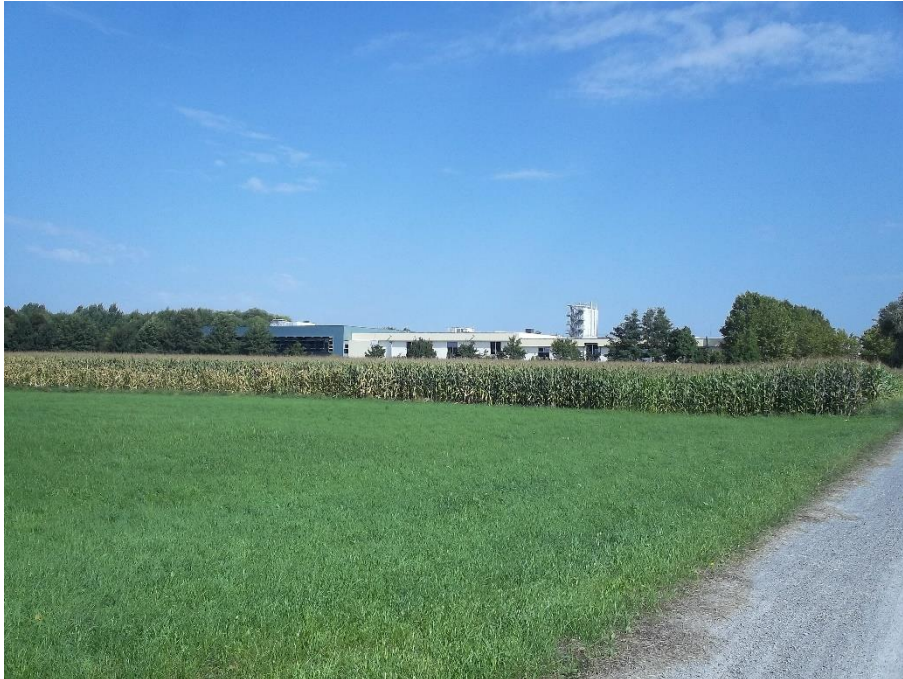
Abbildung 4: Blick über den unbebauten Teil des Plangebiets auf seinen bereits bebauten Teil.
