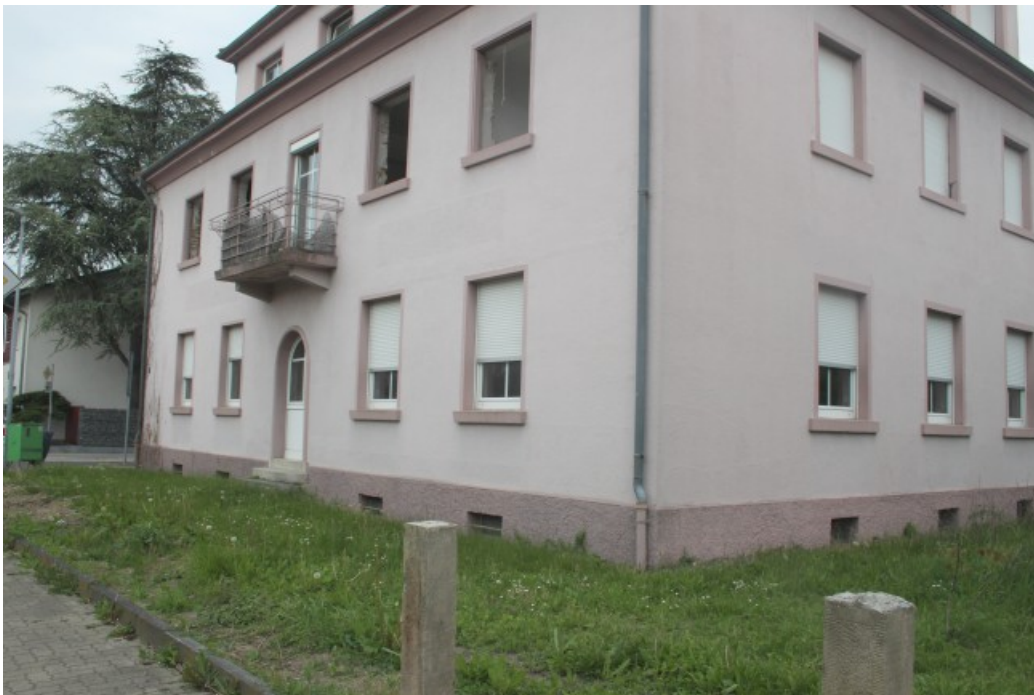
Abbildung 1: Abrissgebäude und Rasenfläche
